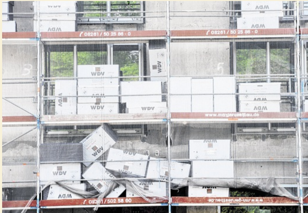
Energetische Sanierungen werden jetzt anders gefördert. Zum 1. Juli startet die Bundesförderung für energieeffiziente Gebäude (BEG). Foto: Tobias Hase/dpa-mag
